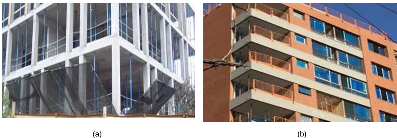
Fig. 2: a) Ejemplo poca singularidad de los proyectos, vanos rectos de geometría estable; y b) Ejemplo problema de singularidad de los proyectos, dimensión de terraza o vano intermedio no permite el uso de protección de borde estándar
