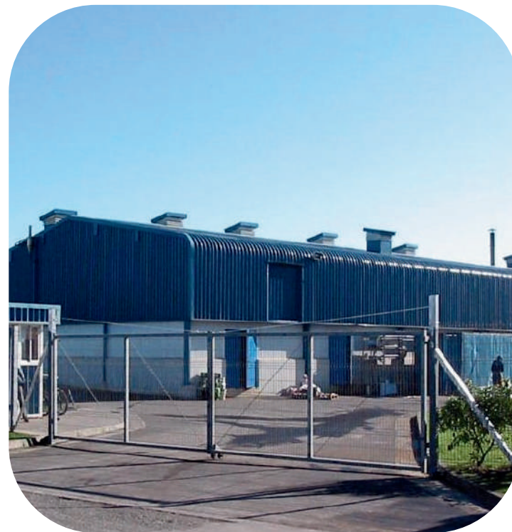
Figura 51 : Instalaciones Tubul Fotografía de elaboración propia.
