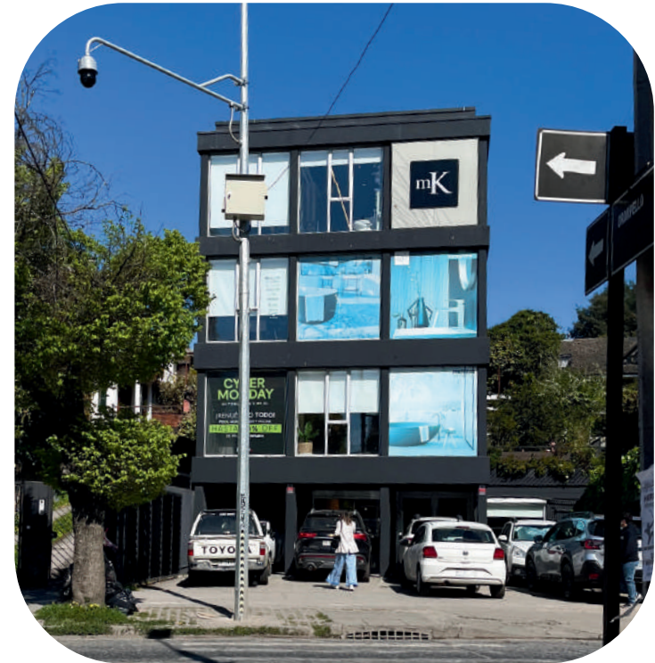
Figura 52 : Instalaciones Mk Concepción Fotografía de elaboración propia.
