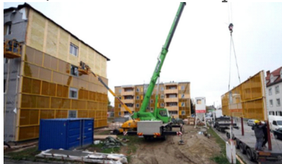
Remodelación e instalación de grandes pasillos en edificio Dinswery. Guaymas, México.
