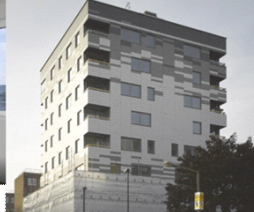
Edificio Suburbano, por E2H fabricados de paneles de madera para edificio de 8 pisos, Lumbini, Inglaterra.
