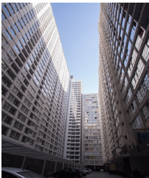
Figura 3 Interior Edificios Continuos
