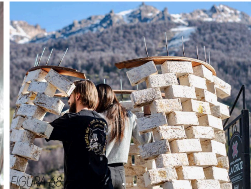
Proyecto Superpraxis, ladrillos de micelio para sistemas constructivos, generando una estructura modular
