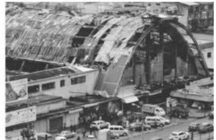
Fig. 11. Fotografía del Mercado Central después del incendio (2013). Fuente: Diario Concepción
