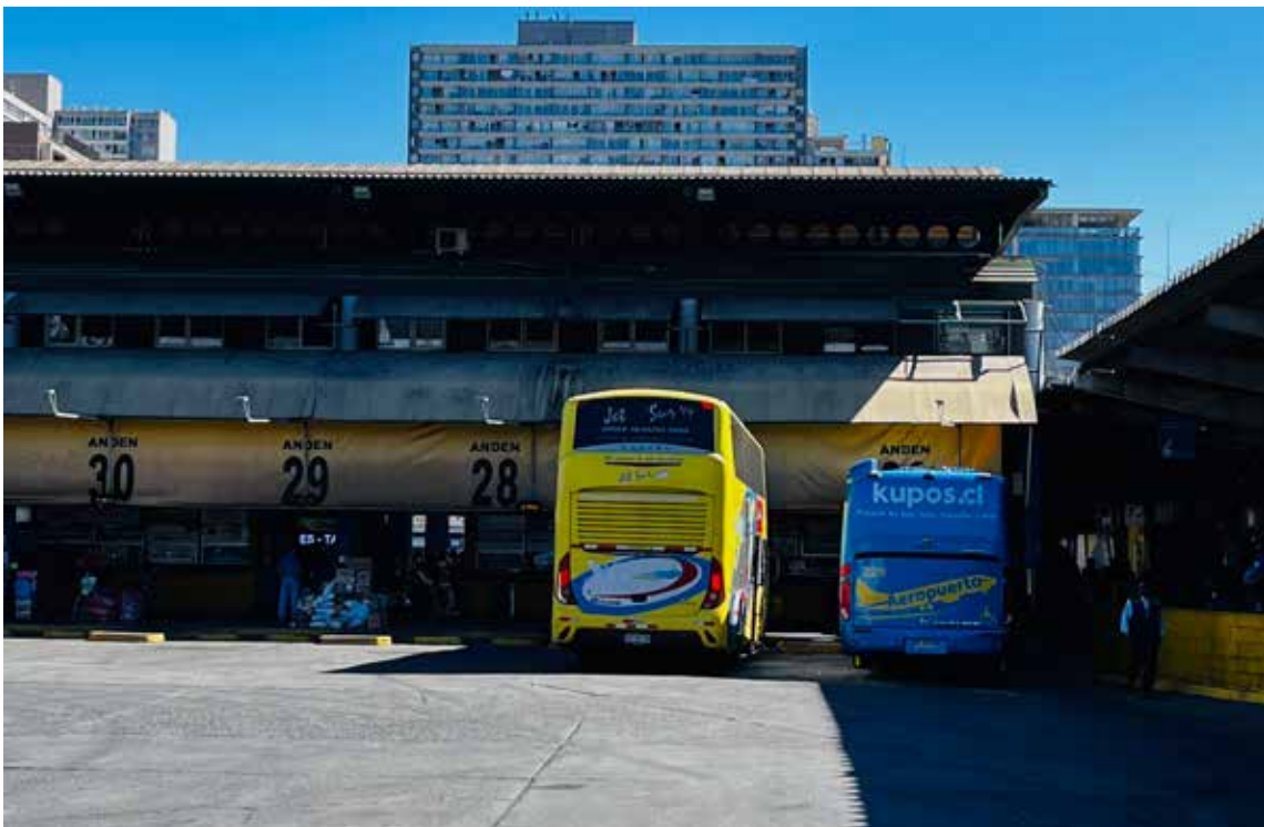
Figura 06: Fotografía que muestra pavimentación urbana en Estación Central en patios de estacionamiento de Terminales de Buses. (Elaboración Propia)
