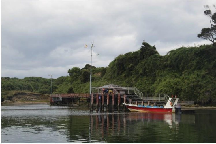
Fig. n.º 18. Muelle existente, Inicio ruta Oxidada. Fotografía propia
