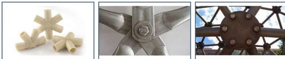
Una sola pieza    Fijados a un mismo punto    Fijados a una placa conectora
