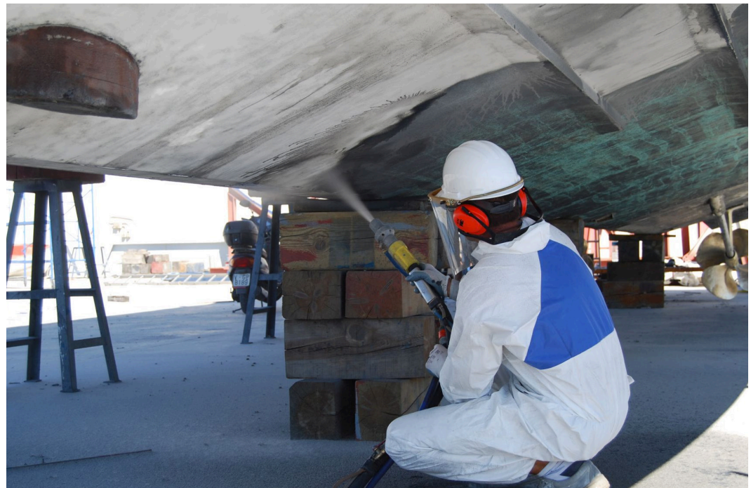
Proceso de Arenado Fuente: Galvanlacados
