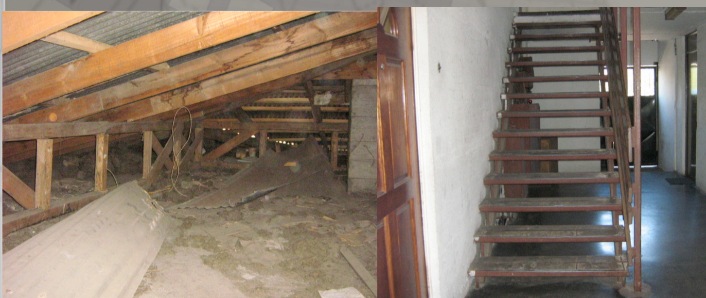
FOTOGRAFIA TECHUMBRE EXISTENTE Y CAJA ESCALA
