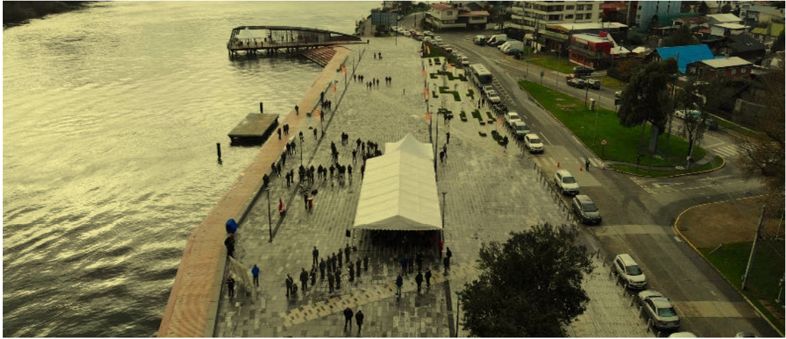
Primer tramo remodelación Archivo El Informador Valdiviano
