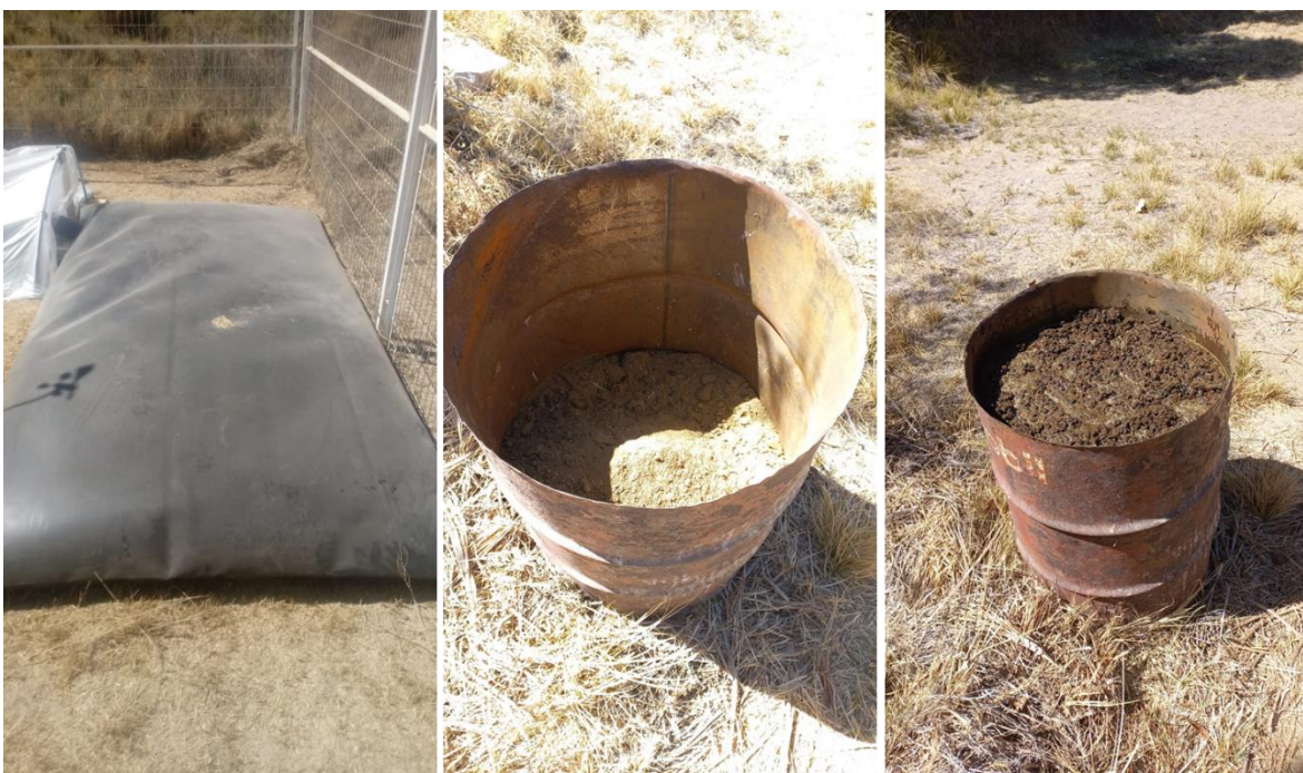
Imagen 10. Conjunto de fotografías del lleno del reactor y la activación con estiércol en Mamiña.
