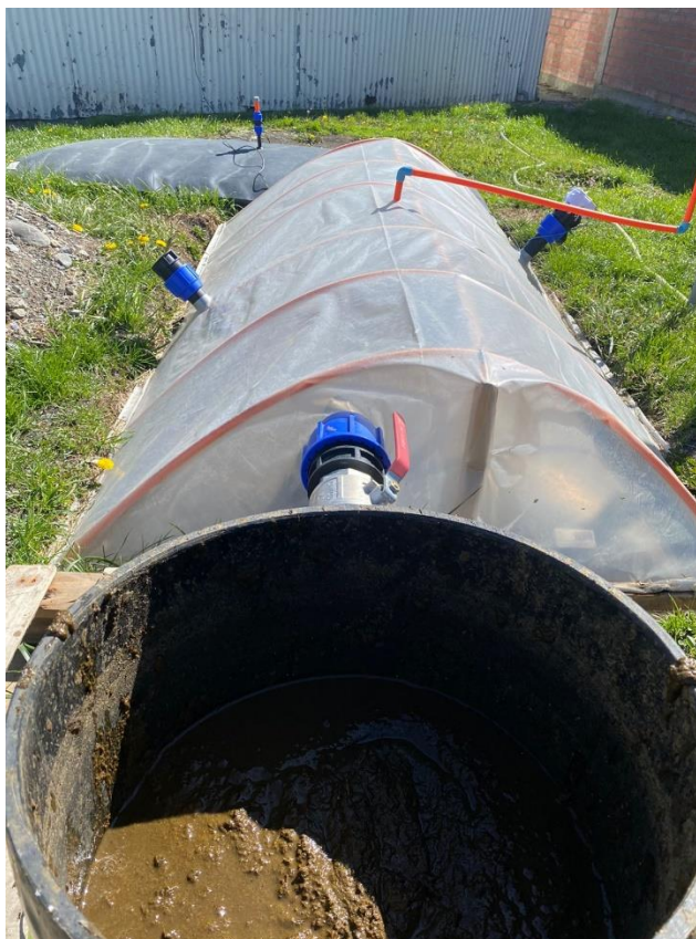
Imagen 11. Fotografía activación con estiércol biodigestor Puerto Natales.
