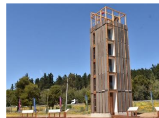
Torre experimental peñuelas, torre de 6 pisos construida con sistema modular. Fuente: CIM UC.
