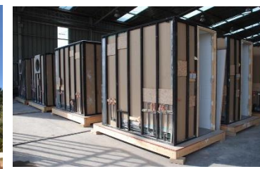
Torre experimental peñuelas, torre de 6 pisos construida con sistema modular. Fuente: CIM UC.
