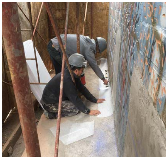
Imagen 98: Instalación sistema EIFS. Fuente: Elaboración propia.
