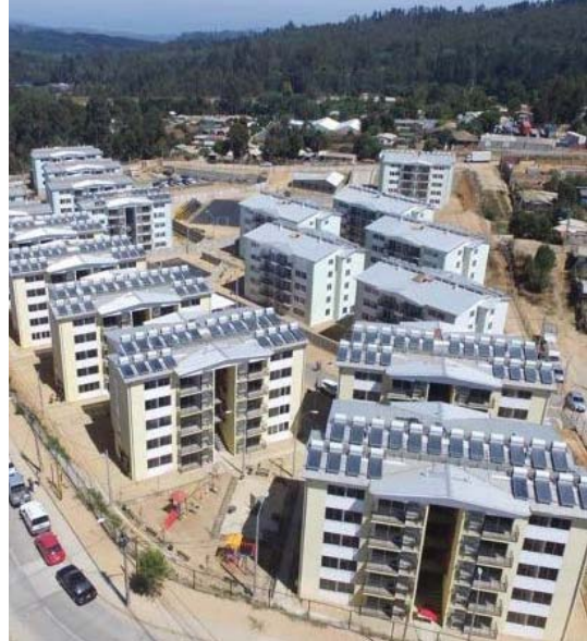
Imagen 118: Sistemas solares térmicos y paneles fotovoltaicos en condominios sociales. Fuente: Elaboración propia.
