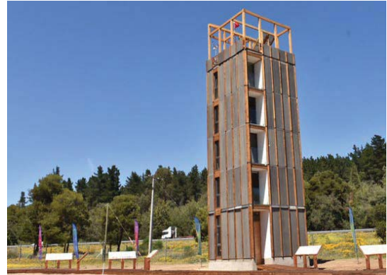
Imagen 105: Torre experimental peñuelas, torre de 6 pisos construida con sistema modular. Fuente: CIM UC.
