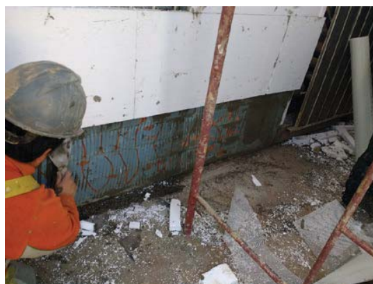
Imagen 100: Instalación sistema EIFS. Fuente: Elaboración propia.
