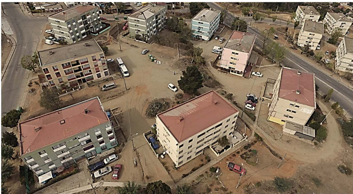
Imagen 61: Vista aérea del Conjunto habitacional Miraflores alto, Viña del Mar. Fuente: René Montaña
