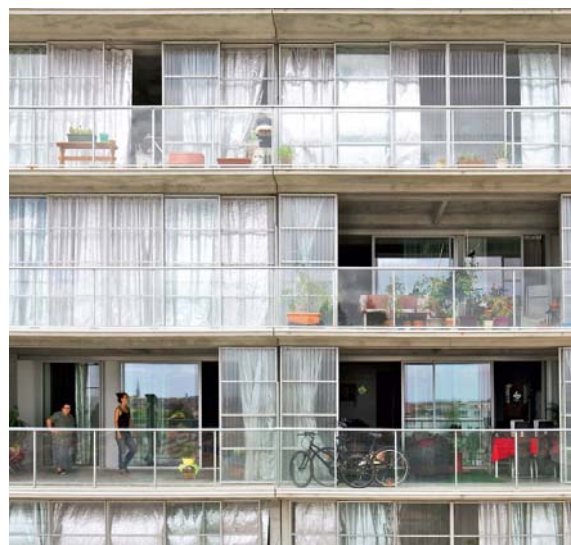
Imagen 07: Fotografía nueva fachada del Cité du Grand Parc. Fuente: http://www.arquitecturaviva.com .
