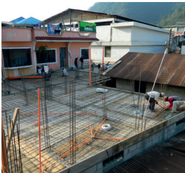
Imagen 7. Casas de remesas en construcción
