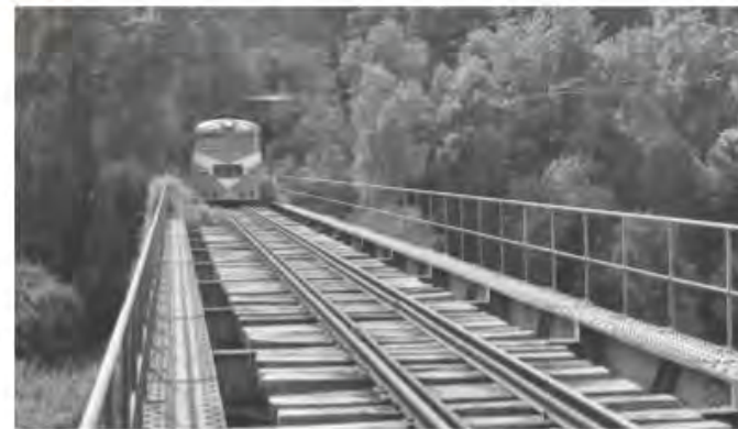
FUENTE: CHARLENE SCHIPMANN NOTA: REHABILITACIÓN FÉRREA RAMAL TALCA - CONSTITUCIÓN
