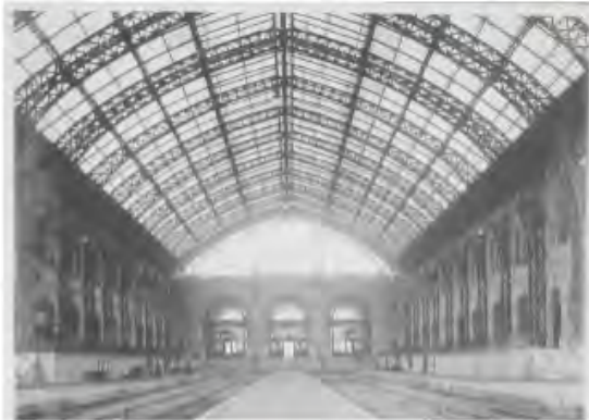
FUENTE: CENFOTO - UDP NOTA: INTERIOR ESTACIÓN CON DOS ANDENES
