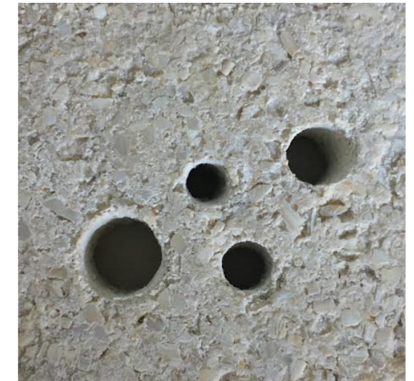
Resultado tras perforación con taladro
