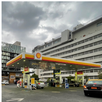
Figura 4: Estación Shell. Registro fotográfico propio de autor.
