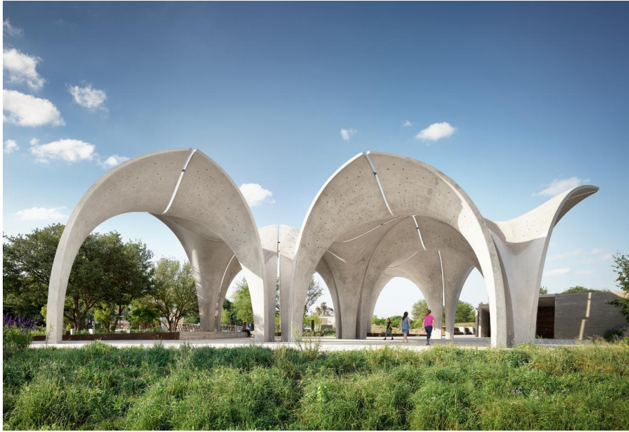
Figura 5 Captador aguas lluvias, Proyecto Confluence park, Flato architects
