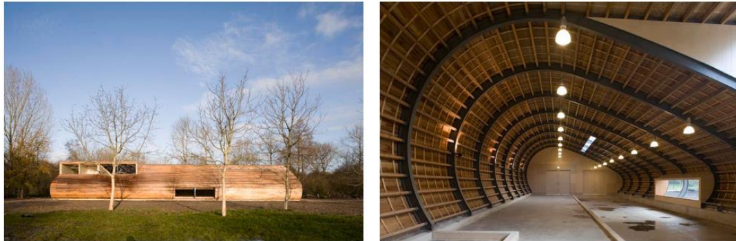
Figura 21 Refugio ganadero, Establo para ovejas, 70F Architecture
