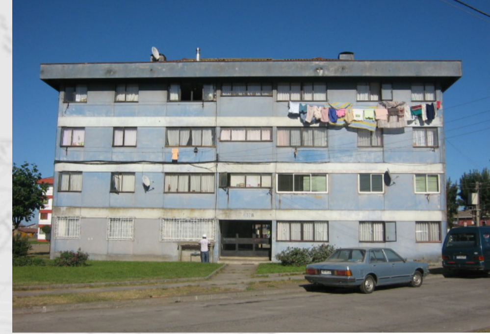
FOTOGRAFIA FACHADA PONIENTE
