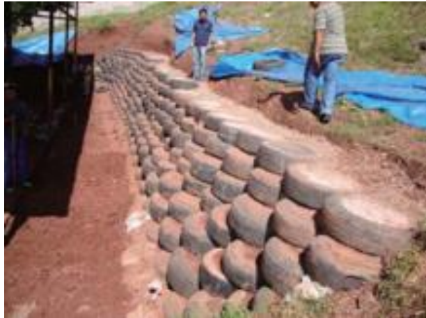
Figura 4. Muro de contención con NFU's.
