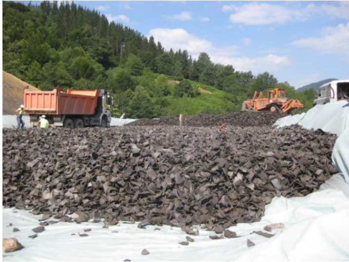
Figura 6. NFU's troceados dispuestos para ser usados en una obra de terraplén
