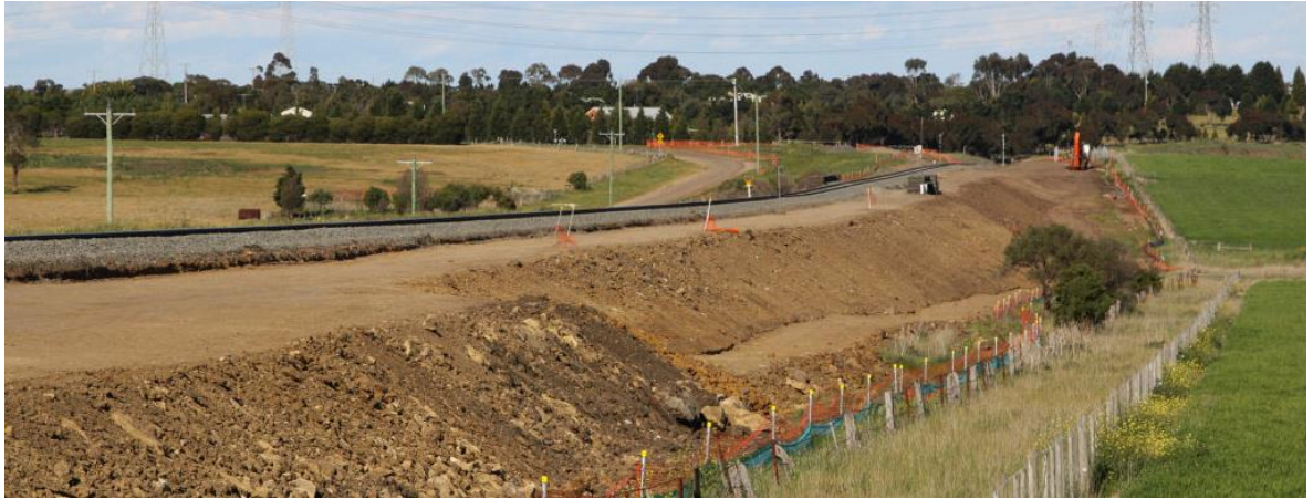
Figura 17. Ejemplo de relleno (terraplén) para la aplicación de NFU's Los análisis de estabilidad han sido desarrollados tanto para condiciones estáticas como pseudo- estáticas, aplicando el modelo de Morgenstern & Price.
