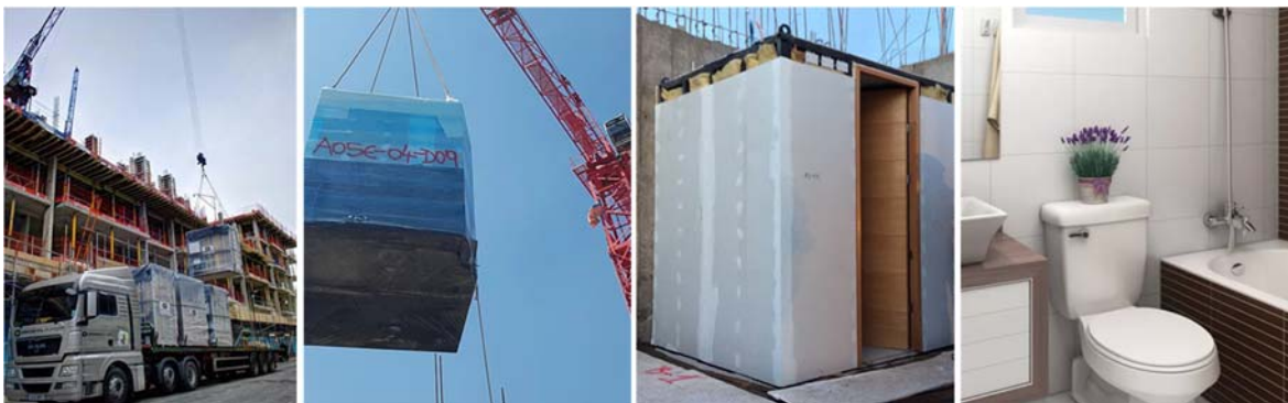
Imagen 81 Sistema de construcción tridimensional de ampliaciones, baños y cocinas. Fuente: https://www.tecnofast.cl
