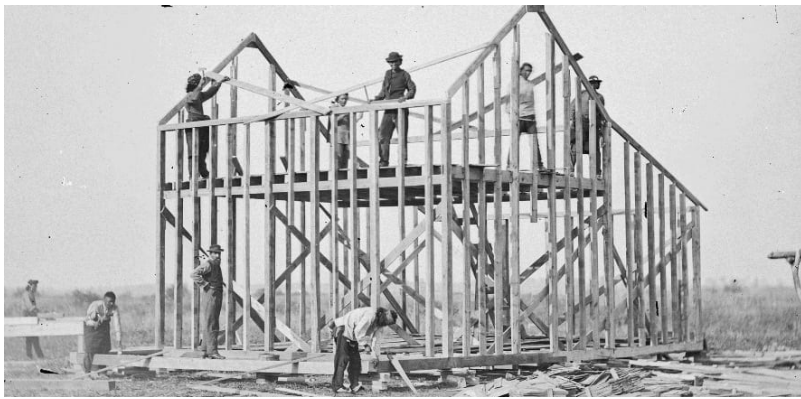
Imagen 10 Construcción denominada Balloon frame. Fuente: www.thecraftsman.blog , por Scott Sidler.
