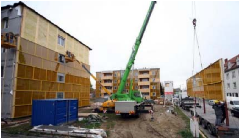
Imagen 23: Instalación de grandes paneles en el edificio Dieselweg, Graz (Austria). Fuente: Retrofit de la construcción mediante paneles prefabricados.
