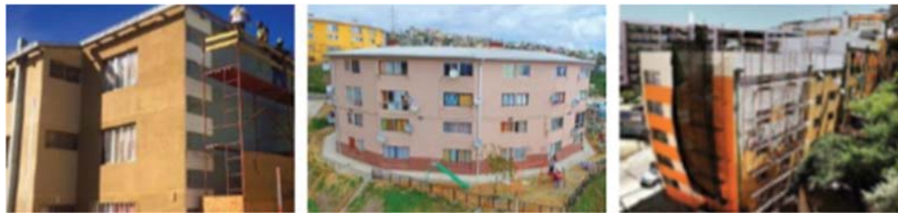
Imagen 02: mejoramiento de condominios sociales existentes en la ciudad de Valparaíso. Fuente: Elaboración Daniela Fuentes C., Arquitecto PUC Valparaíso.
