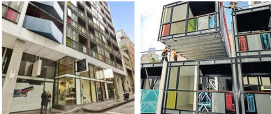
Imagen 16 Fotografías del edificio modular "Little Hero": (a) Después de ser construido y ocupado; (b) Durante su montaje in situ Melbourne, Australia.
