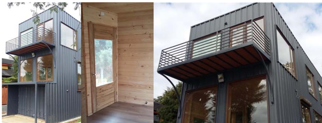
Imagen 28 Vivienda SABINCO prefabricada de módulos, año 2018.
