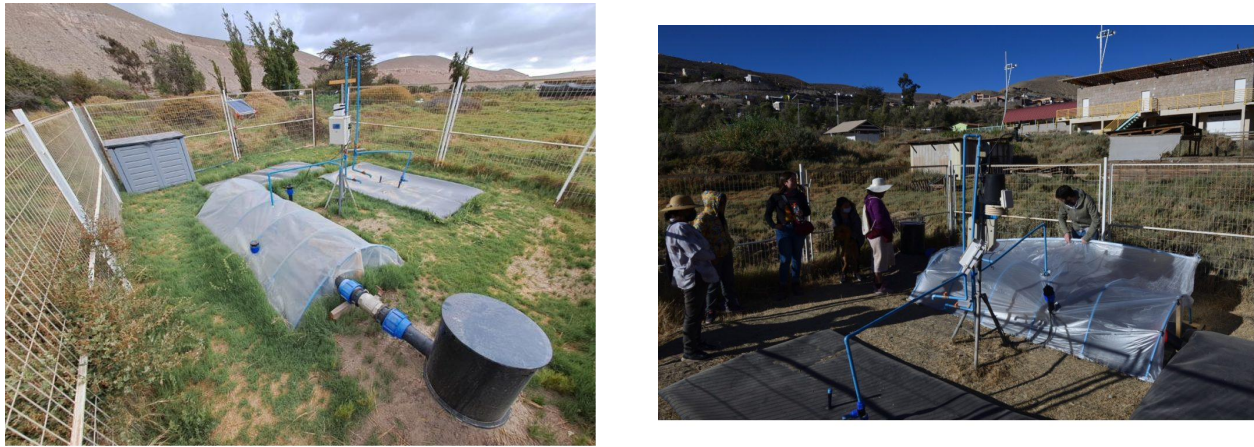
Figura 1.1: Micro biodigestor de Mamiña, Región de Tarapacá, Chile. Reactor tubular de geomembrana instalado a 3000 m.s.n.m. en el desierto de Atacama. Fuente: Facultad de Ingeniería, Universidad del Desarrollo.
