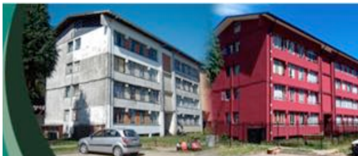
Ilustración 04: Imagen de Mejoramiento de condominios sociales. Fuente:minvu.cl
