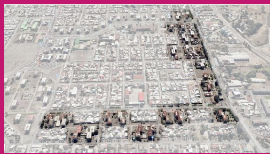
Ilustración 37: Condominio Social Corvi, Av. Colón, Hualpén, Fuente: Google maps.
