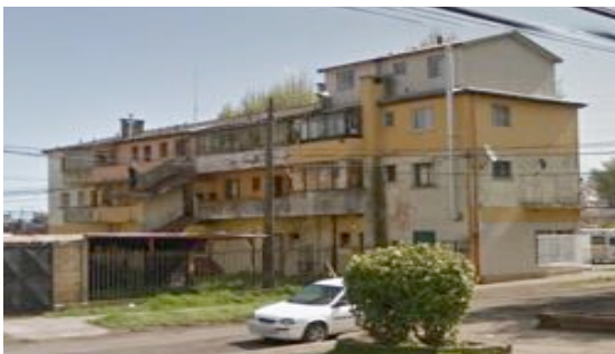
Ilustración 01. Fotografía Condominio social Lorenzo Arenas, Concepción, con modificación de sus propios habitantes. Fuente: propia.
